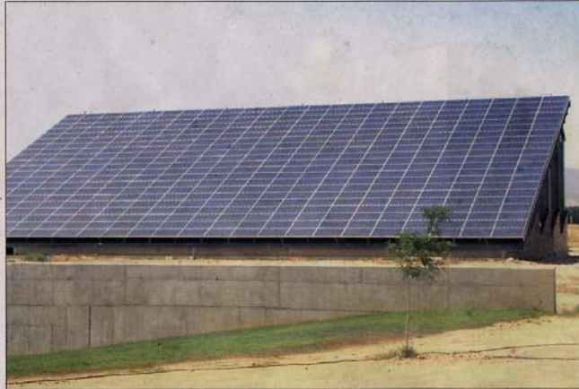
Instalaciones de OX-CTA. VÍCTOR IBÁÑEZ
